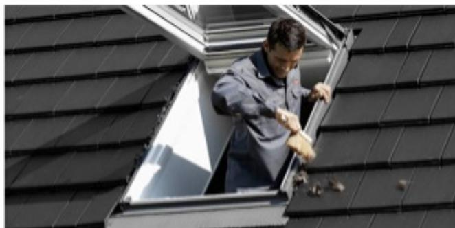
Fig. 2: Elevato rischio di infiltrazioni d'acqua nei raccordi a causa dell'accumulo di sporcizia.
