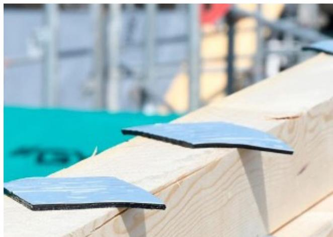
*Fig. 12: Le guarnizioni dei mezzi di fissaggio vengono applicate a rombo sotto il controlistello per agevolare il deflusso dell'acqua.*
